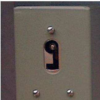
Abbildung 13: Elektrische Schlüsselsperre, ZF-Schlüssel entnommen
