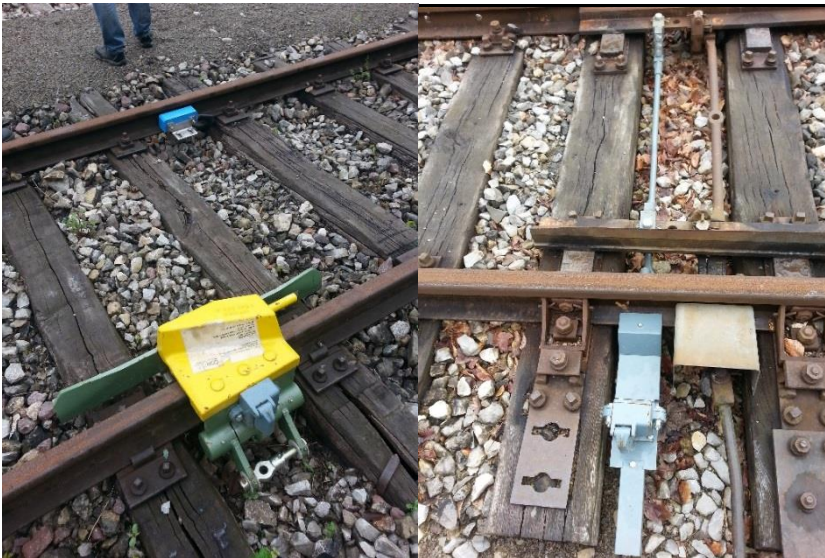
Abbildung 16: Gleissperren- / Weichen-Verschlusseinrichtung (HVE)
